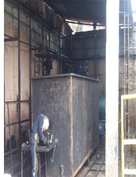
FOTOGRAFÍA 4: TANQUE DE SEDIMENTACIÓN EN CONSTRUCCIÓN
