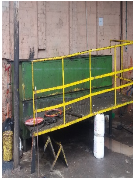
FOTOGRAFÍA 3: TANQUE DE SEDIMENTACIÓN
